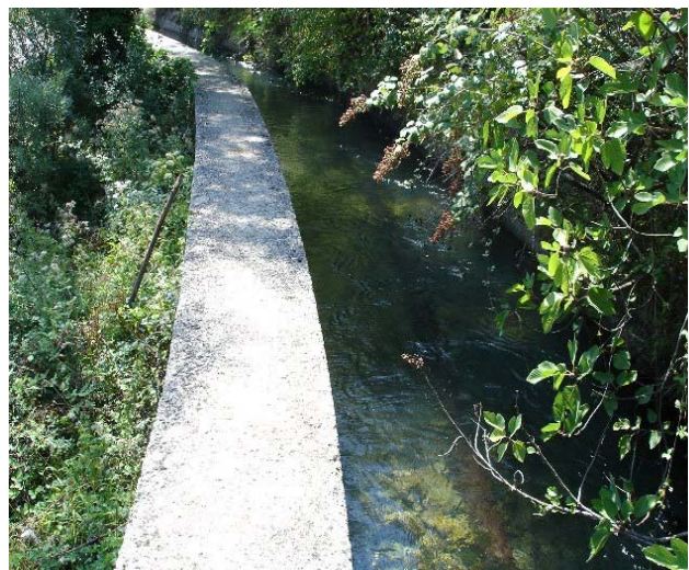
Slika 17 Objekat sistema navodnjavanja - jedan od dva glavna kanala iz vodozahvata na izvoru Lištice
