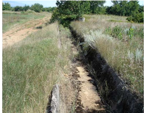
Slika 15 Objekat sistema navodnjavanja - kanali
