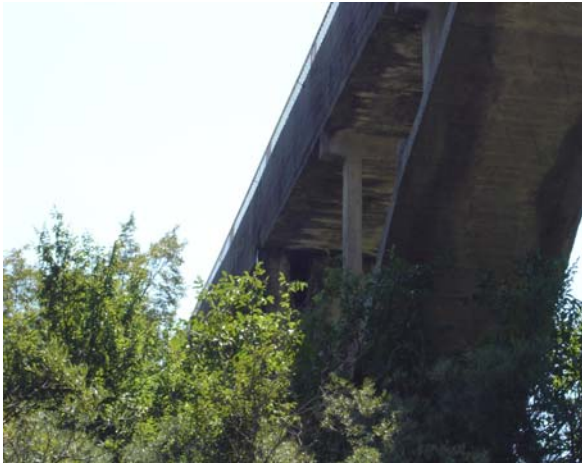
Slika 14 Objekat sistema navodnjavanja - akvadukt
